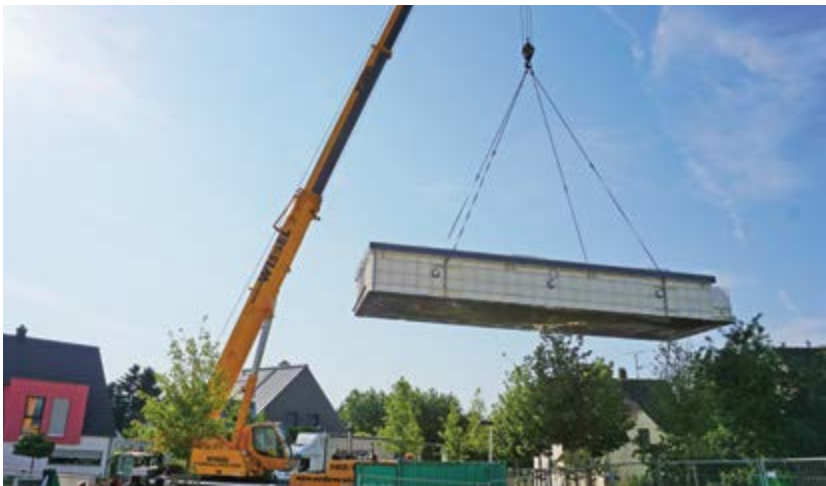
↑ Une grue dépose le bassin préfabriqué dans le trou préalablement réalisé et dont le sol a été bétonné.
